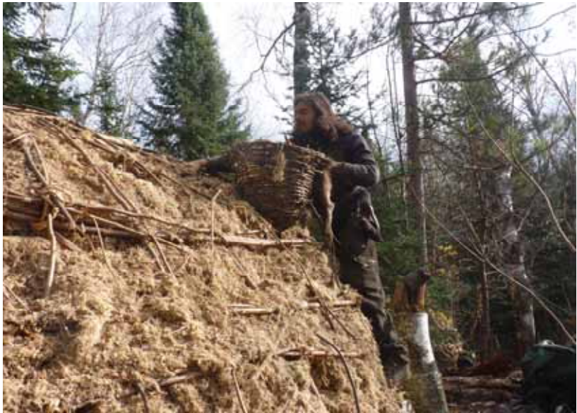
Das Winterwigwam bekommt eine neue Torfmoosisolierung
